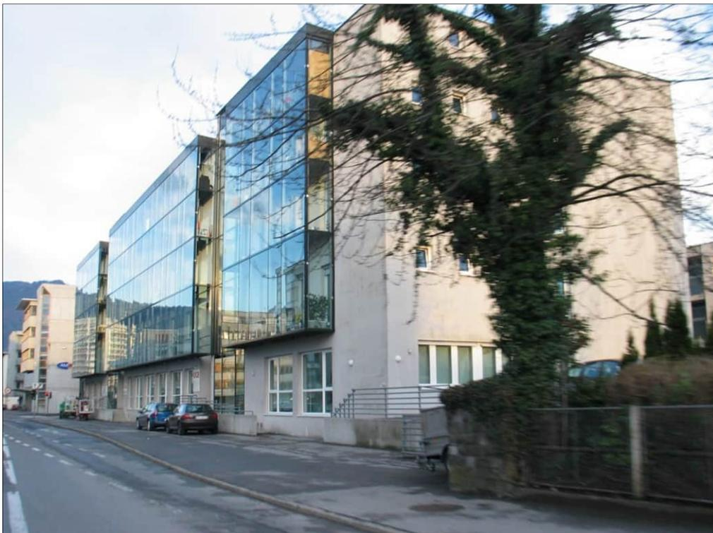
Abb. 12: Ausführungsbeispiel für eine (verglaste) Doppelfassade bzw. Loggia
