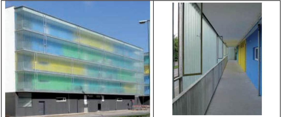
Abb. 10: beispielhafte Darstellung (Außenansicht und Innenansicht) der baulich-konstruktiven Maßnahme verglaster Laubengang [Quelle: Lärmschutzbaukasten Juni 2005, Faltblatt Nr. 3, Referat für Stadtplanung und Bauordnung LHS München]
